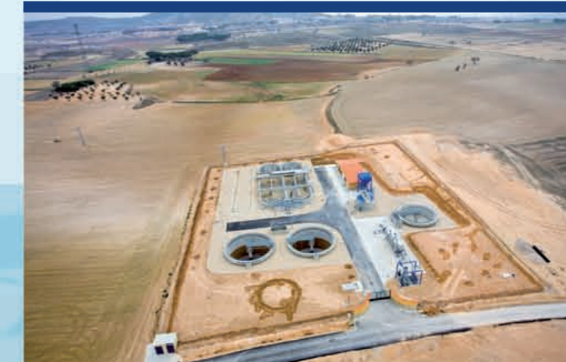
EDAR de Chinchilla de Montearagón
